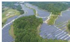
◀こんぶらレイク太陽光発電所 16.1Mw
